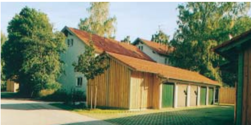
Nach der Sanierung: großzügige Garagen
