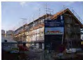
In der Brauneckstraße in Aschheim...
